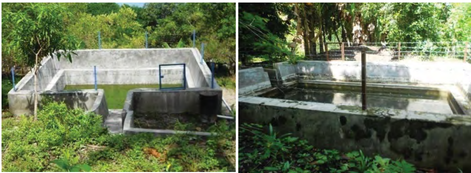
Gambar 3. Kontruksi bangunan pemanenan air di Kota Ternate.
