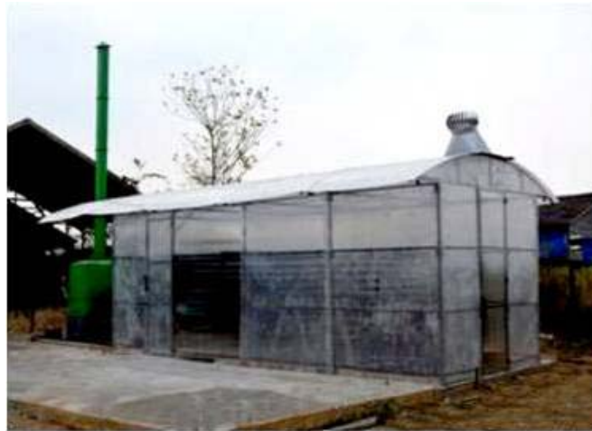
Gambar 3. Bangunan pengering hybrid dengan tungku biomasa dan blower .
